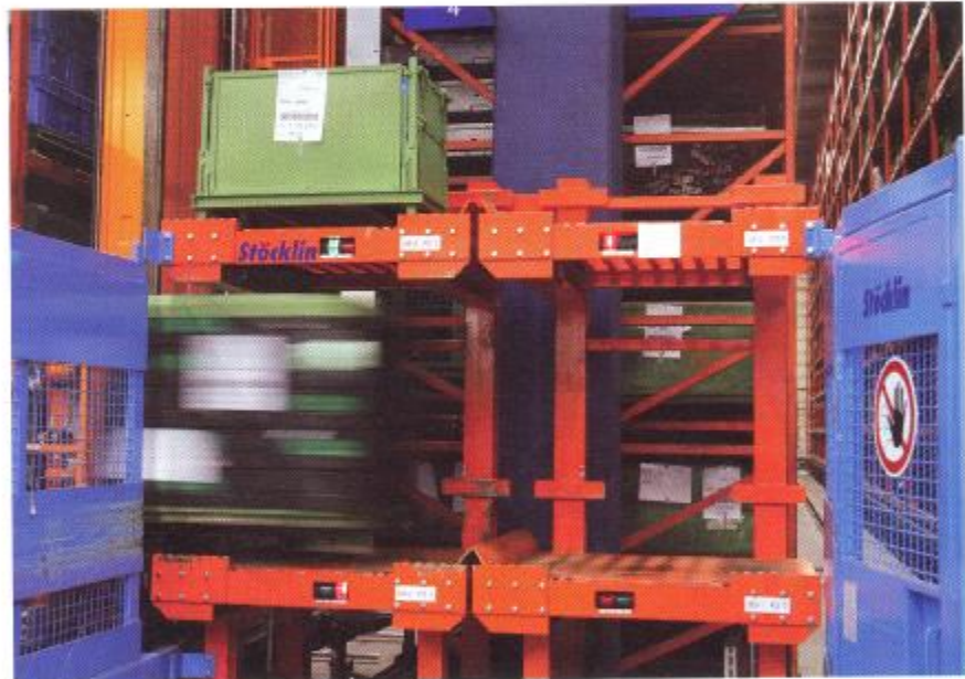
Bild 1 Regalbediengerät in Aktion - Aufnahme eines Behälters von der Aufgriffstation.
